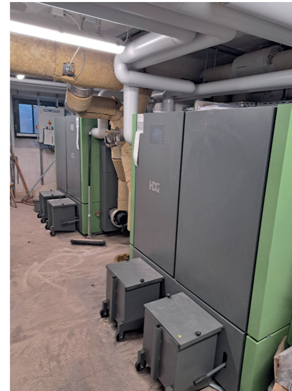
Hackschnitzelheizung mit 2 Kesseln © Bezirksverband Pfalz
