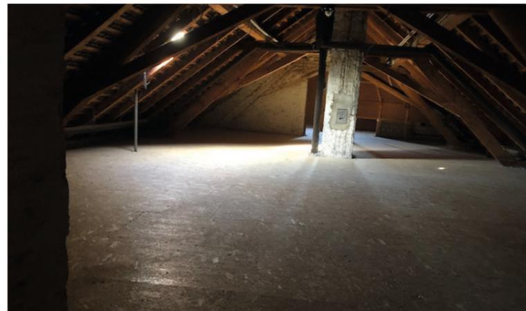
Fertig sanierte Geschossdecke, mit OSB-Platten verlegt zur Begehbarkeit | © Bezirksverband Pfalz
